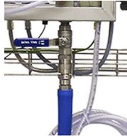
4. ➤ Kugelhahn unterhalb des Foamatic-Satelliten öffnen.
