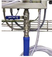
4. ▶ Kugelhahn unterhalb des Foamatic-Satelliten öffnen.
