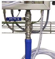
5. ➤ Kugelhahn unterhalb des Foamatic-Satelliten öffnen.
